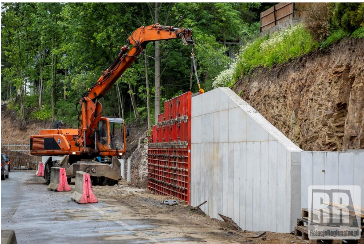
Fot. Remont drogi wojewódzkiej.
