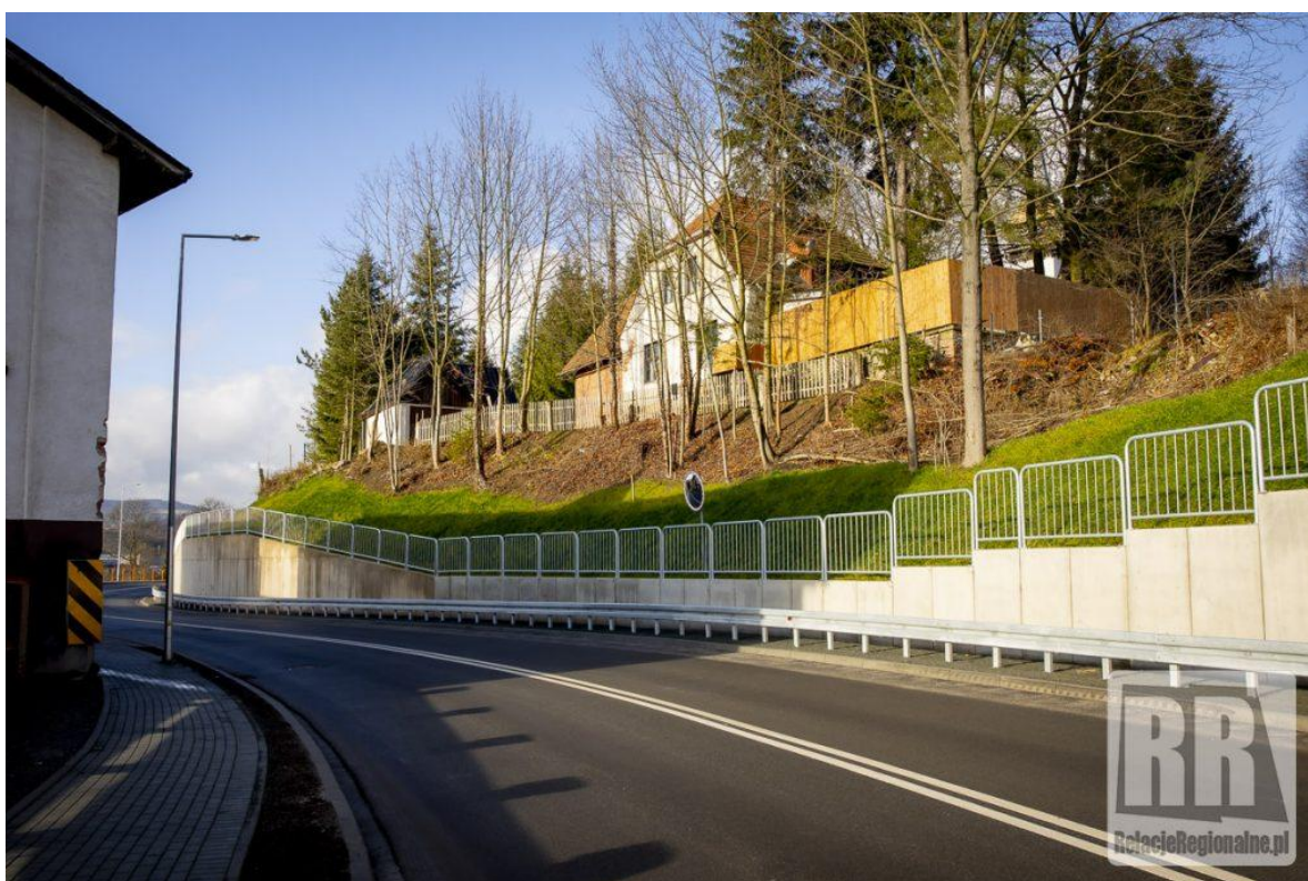
Fot. Remont drogi wojewódzkiej.
