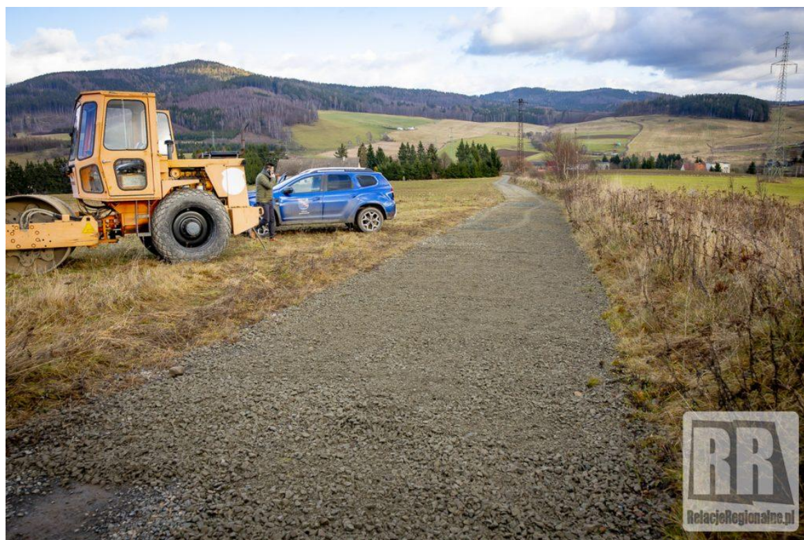
Fot. Remont drogi gminnej 114502 w Marciszowie.
