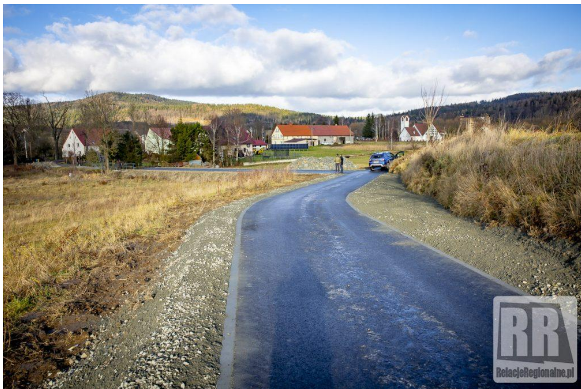
Fot. Remont drogi gminnej 114377 w Sędziszawiu.
