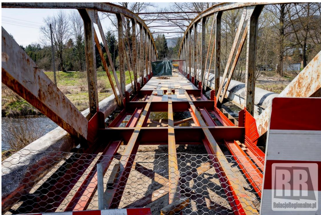
Fot. Most w Marciszowie.
