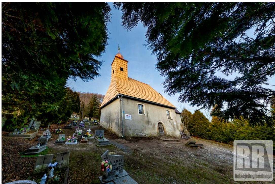
Fot. Remont dachu kaplicy cmentarnej w Wieściszowicach
