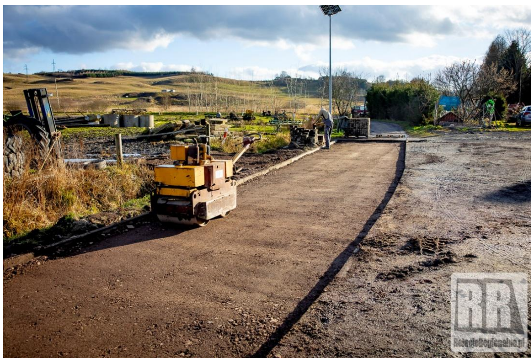
Fot. Remont drogi gminnej 114372 w Marciszowie
