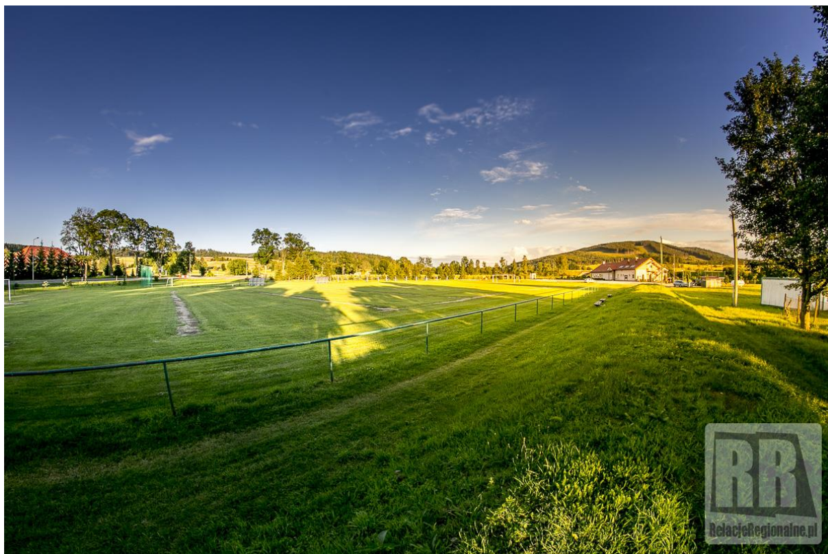
Zdjęcie nr 4 Rozbudowa Gminnego Centrum Sportowego w Marciszowie – przed rozpoczęciem robót
