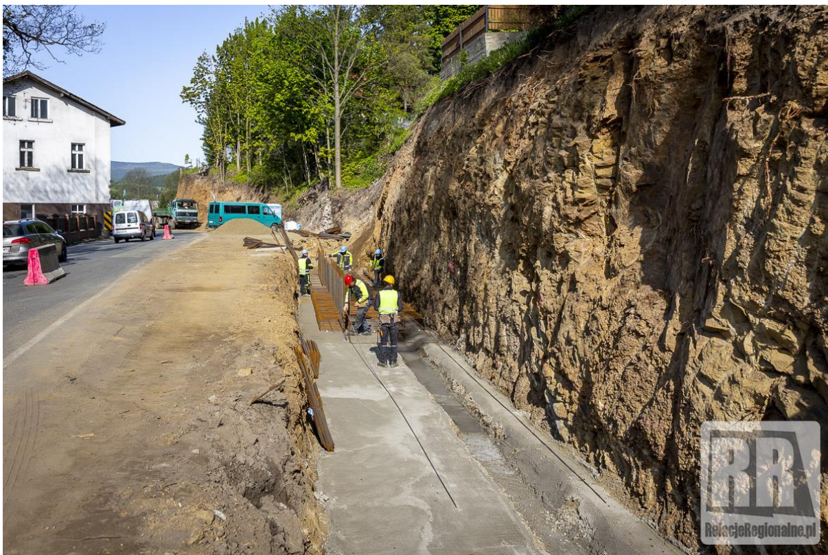
Zdjęcie nr 3 Przebudowa drogi wojewódzkiej nr 328 w Marciszowie – w trakcie robót
