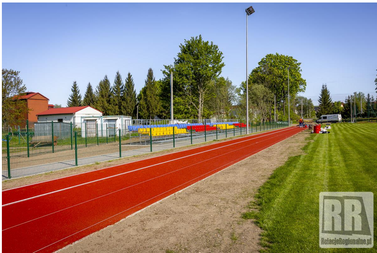
Zdjęcie nr 6 Rozbudowa Gminnego Centrum Sportowego w Marciszowie – w trakcie realizacji prac
