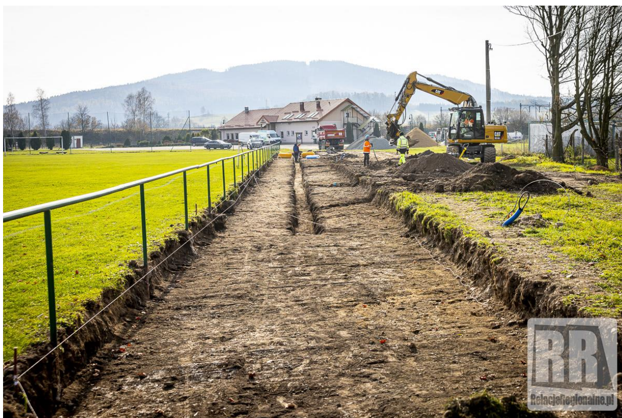
Zdjęcie nr 5 Rozbudowa Gminnego Centrum Sportowego w Marciszowie – początek prac
