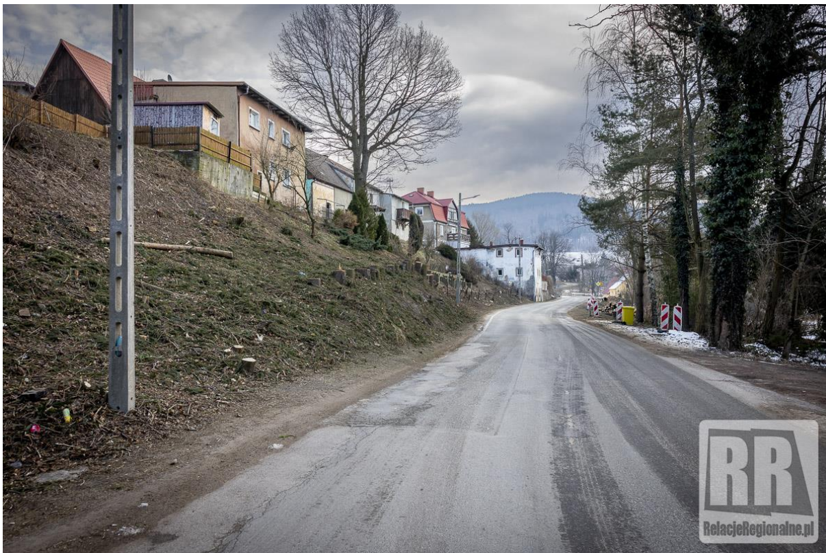
Zdjęcie nr 2 Przebudowa drogi wojewódzkiej nr 328 w Marciszowie – rozpoczęcie prac
