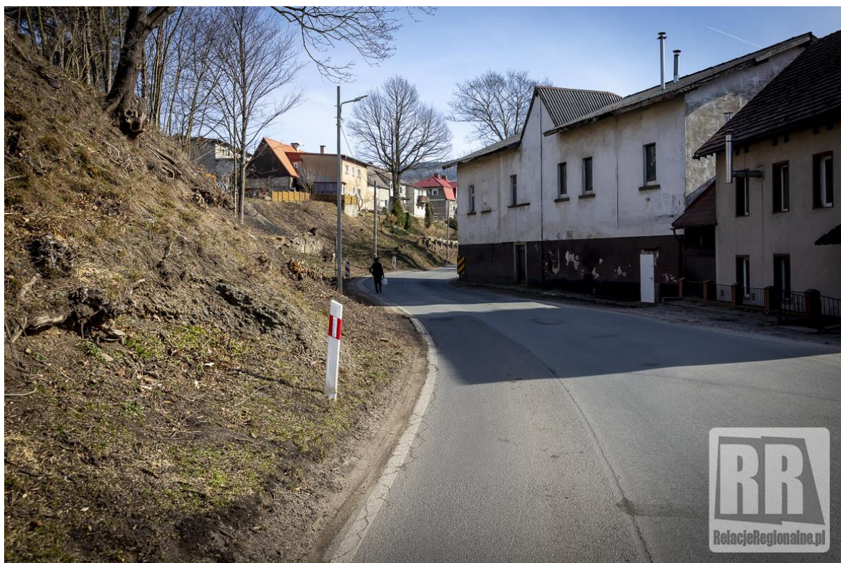
Zdjęcie nr 1 Przebudowa drogi wojewódzkiej nr 328 w Marciszowie – rozpoczęcie prac
